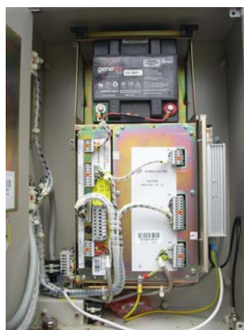
b) Ugradnja radio-modema
