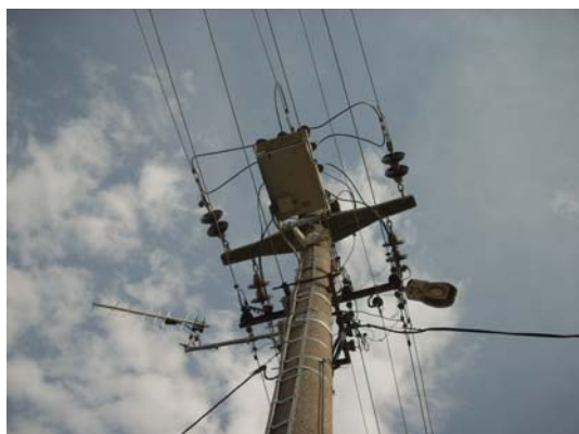
a) Instalacija antene na stub
