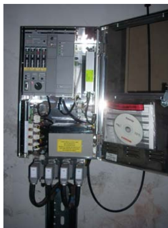
Slika 8 – Integracija daljinske stanice i telekomunikacione opreme
